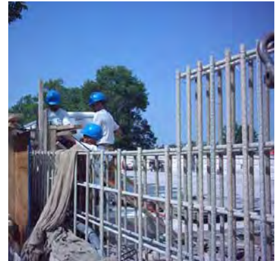
Brüstungsbewehrung mit FIBERNOX® bei einer Brücke
