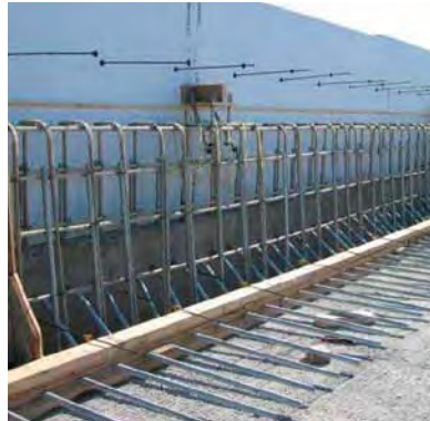
Brüstungsbewehrung mit FIBERNOX®-Bügeln bei einer Brücke
