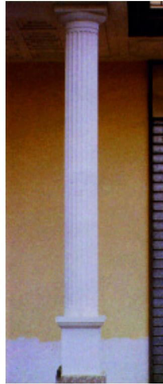
Strukturstütze mit Balustrade und Kapitell
