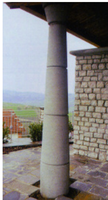
Konische Stütze mit Einschnürungen
