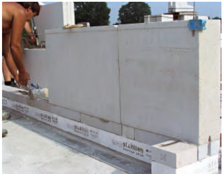
Vermauern als unterste Schicht im Mauerwerk
